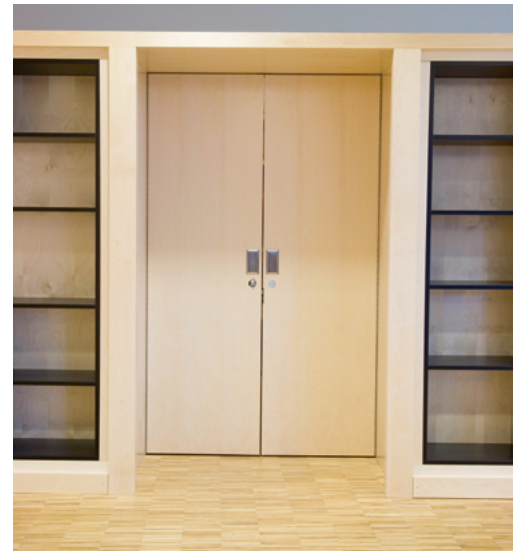
Dører som «forsvinner» inn i vegg, skaper både låsemuligheter og tilgjengelighet.
