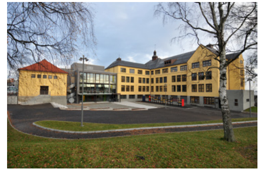
Oversikt mot nybygg med tydelig inngangsparti og vestibyle.
