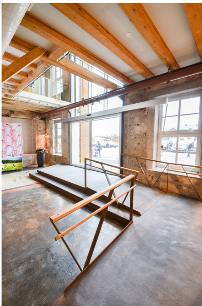
Nytt møter gammelt i Devoldfabrikken på Sula. Glass og stål står i kontrast til upusset tegl og gammelt reisverk. Hans Brattruds elegante Scandia-stol fra 1957 (i nyere produksjon av Fjordfiesta) er benyttet i selskapsavdelingen.
