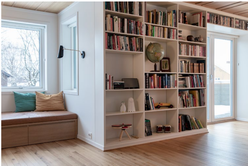
Bokhyllen ble fullintegrert i døråpningen til balkongen slik at smyg og bokhylle består av samme plate og skaper en sømløs overgang.
