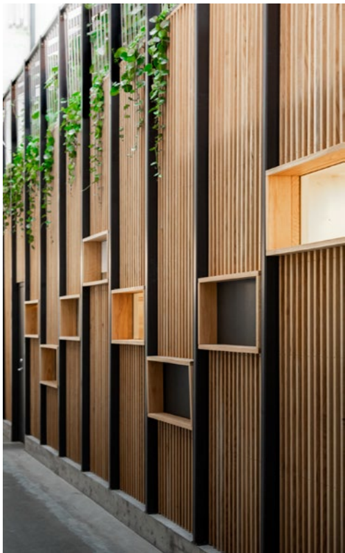
Stålrammene er ikke sveiset, men skrudd fast på plassen, i likhet med alle trespilene. I prinsippet kan dermed denne tre- og stålkonstruksjonen demonteres.
