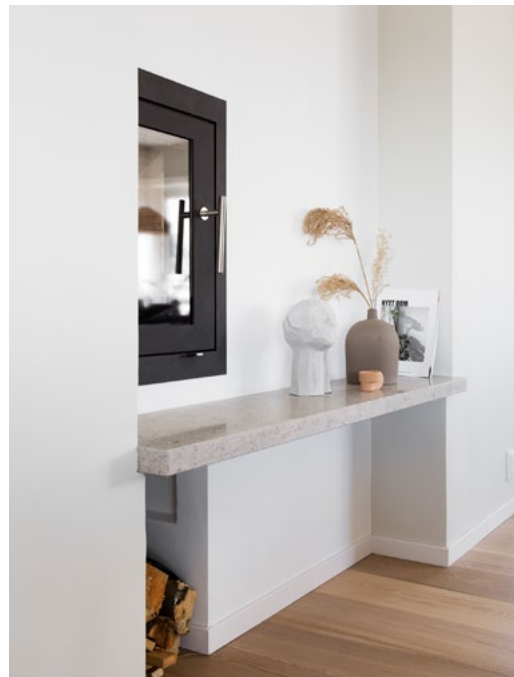
Det eksisterende pipeløpet ble endelig utnyttet da nishen i veggen fikk en peisinnatts. I forkant ble det montert en hylle i naturstein for å beskytte gulvet. Rommet på undersiden av hyllen brukes til ved.
