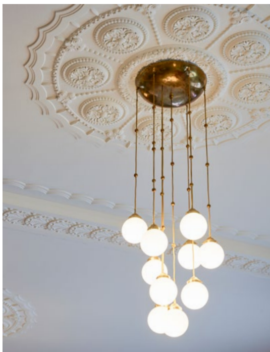
Den eksisterende himlingen i El Greco-salen ble restaurert, og den eksisterende pendellampen ble oppgradert med nye lyskilder.
