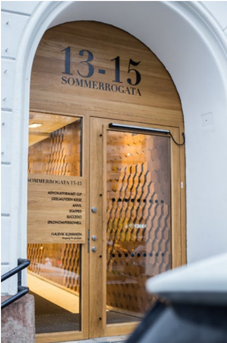
Eksisterende tette inngangsdør inn til Sommerrogata 13/15 ble erstattet med en dør med mye glass. Dette for å få mer kontakt mellom ute/inne.
