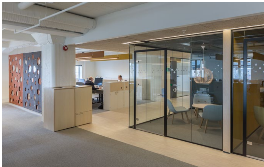
Gulvbelegg og himling hjelper til å definere kjernen fra arbeidsplassene som har bafler i himling og filtheng som lydabsorberende elementer. Disse danner også den ytterste av ringene i konseptet.
