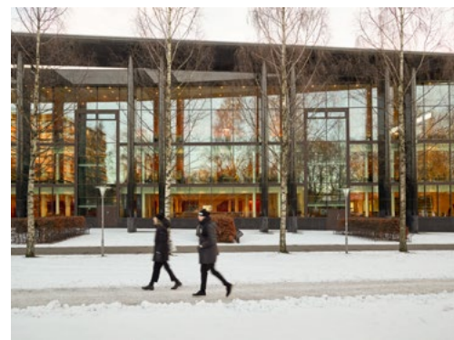
Ved å rive de eksisterende kontorene mot fasaden ser man nå helt inn til den røde veggen som er byggets kjerne.
