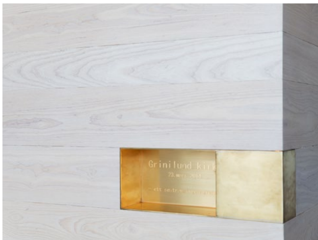
Den innfelte messingboksen der menighetens visjon og dato for nyåpningen er inngravert opptre som en hjørnestein i askeveggen.
