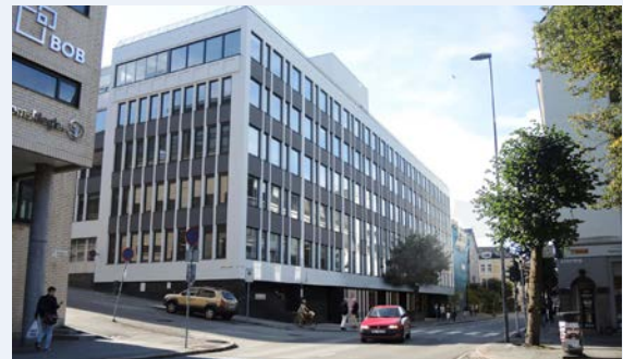
1 Nygårdsgaten 5 - Universitetet i Bergen (Brødrene Ulveseth) Materialer, bygningsskomponenter og møbler.
