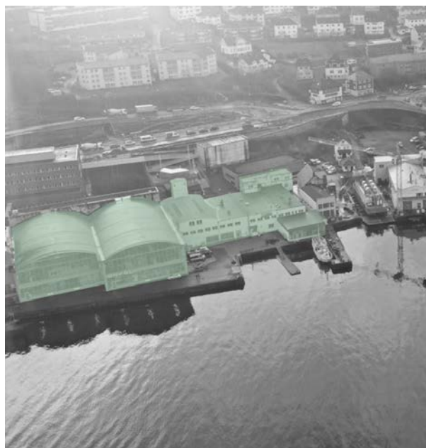
Flyfoto av Damsgårdsveien 112-113. Valgt bygning er markert.
