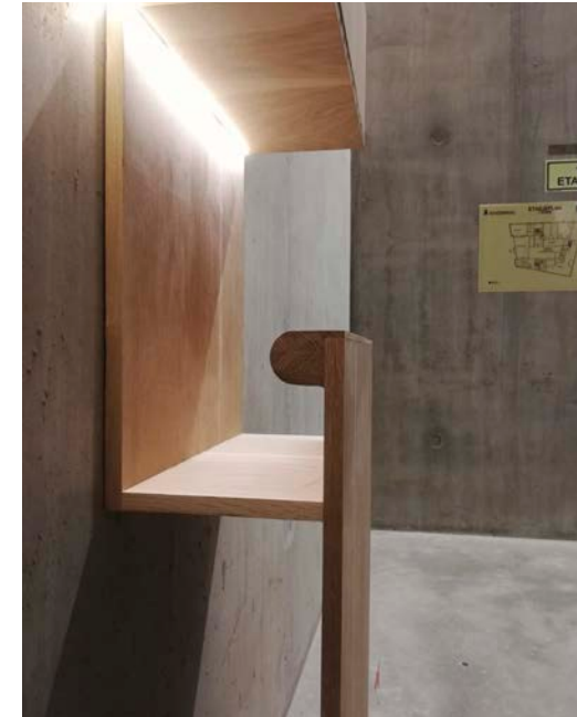
Profil fra ledevegg i 1:1. Ledlys skaper orientering og gjør at brukeren finner ledeveggen i arkitekturen.
