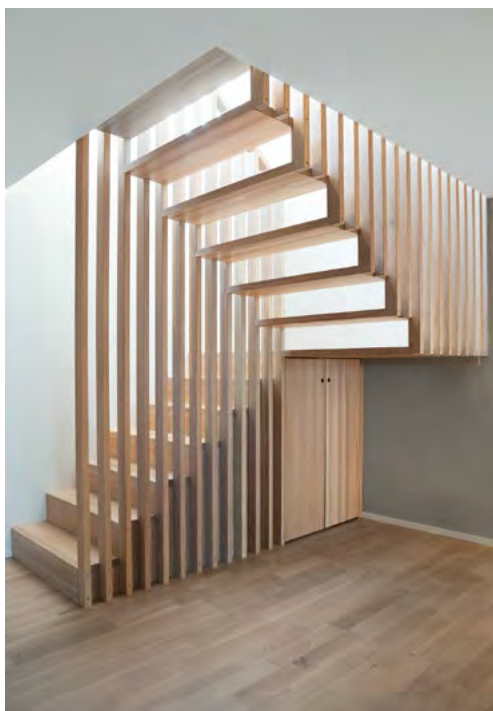
Trappen sett fra underetasjen – lyset siles fint gjennom spilene og gir dagslys ned i underetasjen hvor det tidligere var helt lukket.
