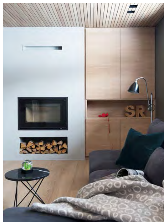
Ny peisinnsett er satt inn i eksisterende teglstenskonstruksjon. Fast innredning i forlengelse av peisen.
