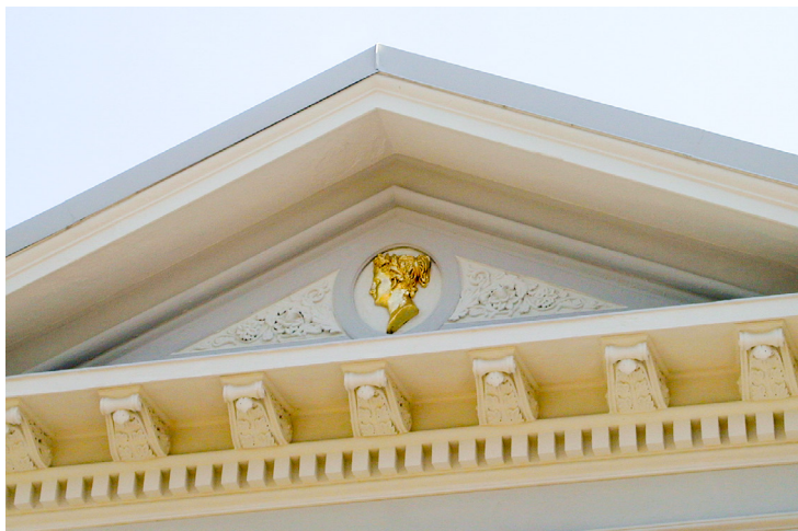
Arkitektenes hus, Josefinegate 34 er tegnet i 1877 av arkitekt M.J. Larsen. Bygningen ble tegnet som en tomannsbolig i nyrenessansesstil. Gjennom årene har bygget hatt en rekke forskjellige funksjoner. Fra Frøken A. Conrads Pigeskole til Pastor Hallings skole for gutter og til Rudolf Steinerskolen. Foto ->NAL v/Tom Andresen
